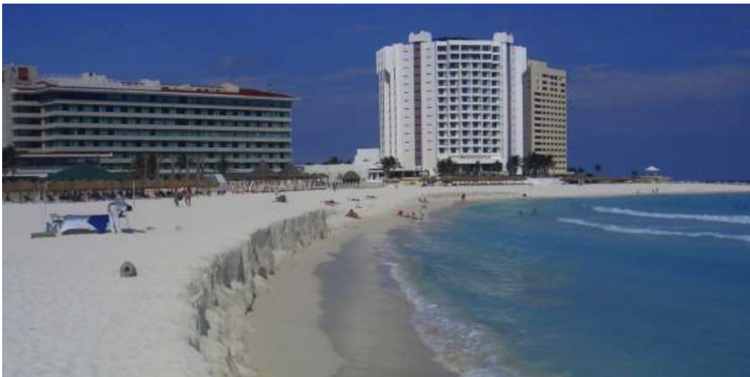
Het strand van Cancun wordt onderhouden door regelmatige zandsuppletie, maar beginnen onmiddellijk te eroderen. Foto: Rodolfo Silva
