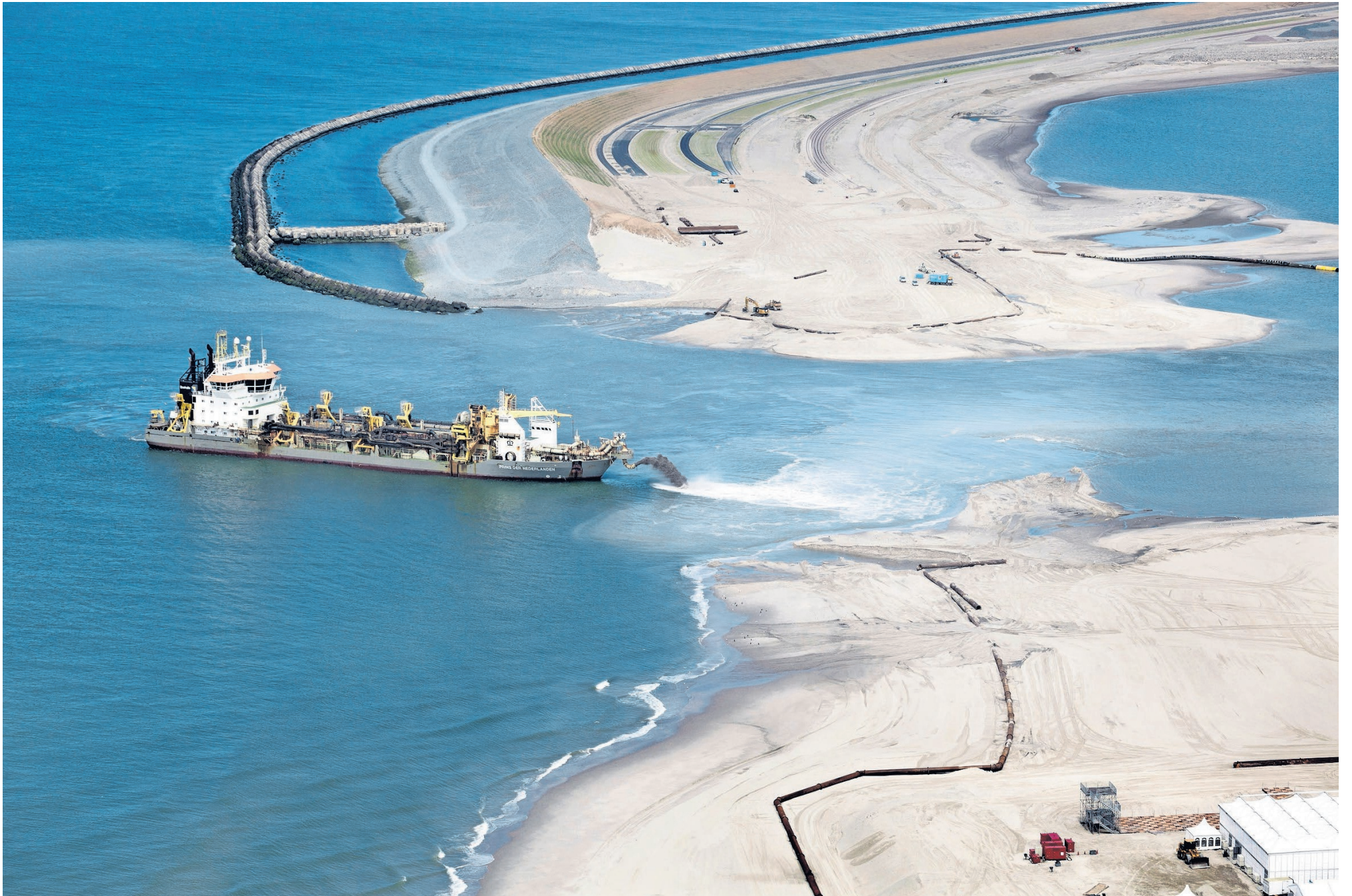
Aanleg van de Tweede Maasvlakte. FOTO MIRANDE PHERNAMBUCQ PHOTOGRAPHY, ANP
